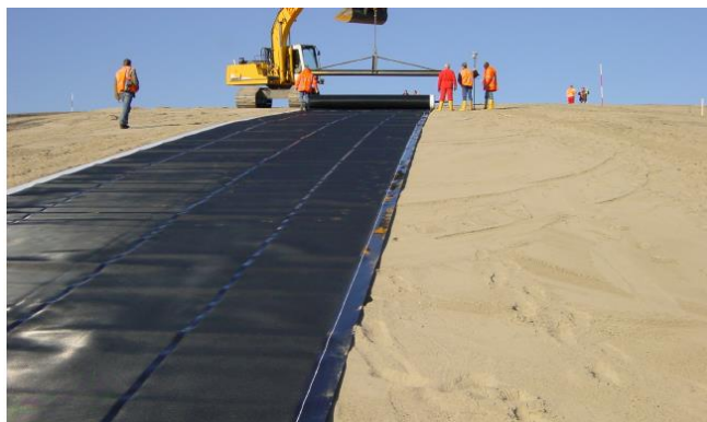
شکل 3: ساخت یک آستر نفوذناپذیر از پلی اتیلن پرچگالی
