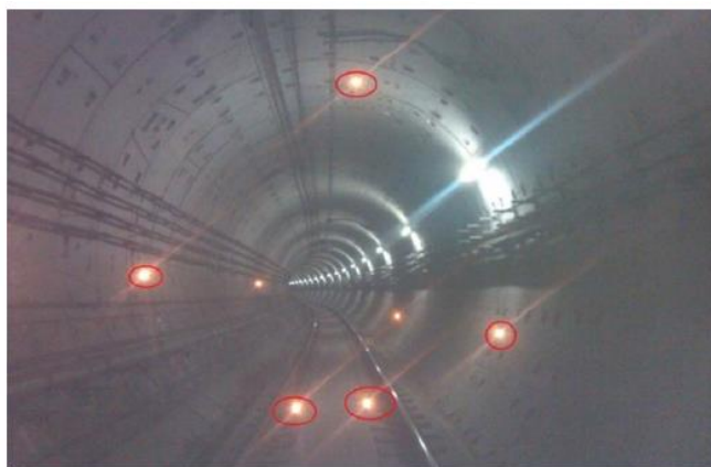
شکل 8 - نقاط اندازه گیری منشورها یمنعکس کننده
